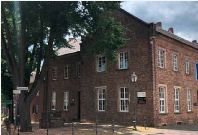
Abbruch Hofanlage Lindenstraße
